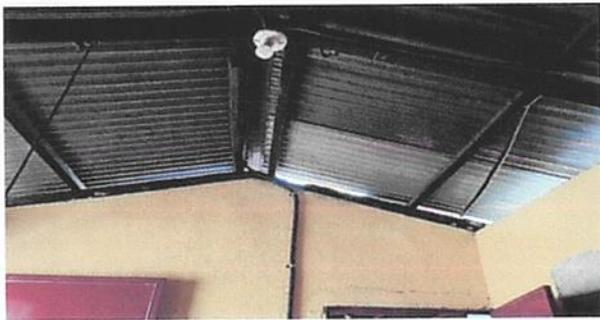
Foto 3: Cocina: Costaneras y lámina en mal estado.
