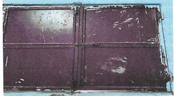
Foto 4: Deterioro de ventanas, puertas y balcones por falta de pintura.
